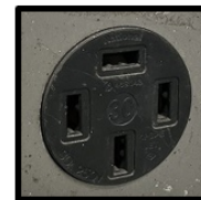
200V 30A (Triple Phase 50Hz)
